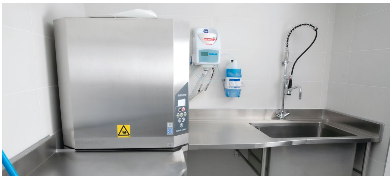
Environnement laverie sur mesure. ✓
