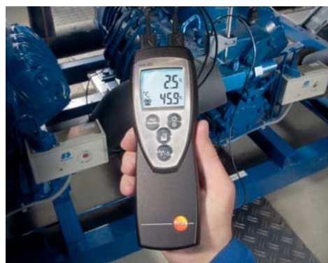
Mesures simultanées des températures de surchauffe et de sous-refroidissement sur une installation frigorifique
